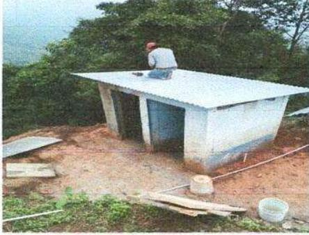
Foto1: 1. CUBIERTA DE LÁMINA EN BAÑO
