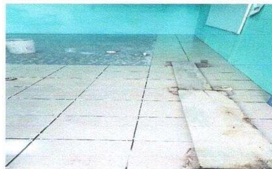
Foto 12: 6. SUSTITUCIÓN DE PISO DE CEMENTO LÍQUIDO POR PISO CERÁMICO
